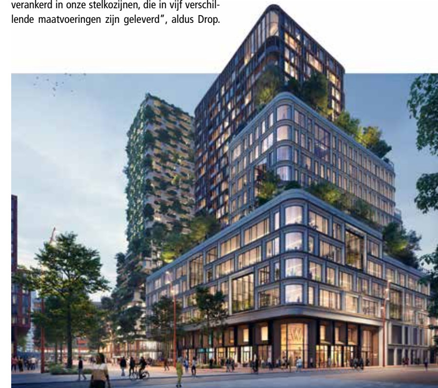
In de MVSA-toren is het deel met de sandwichbetonnen gevelelementen voorzien van kunststof stelkozijnen.
